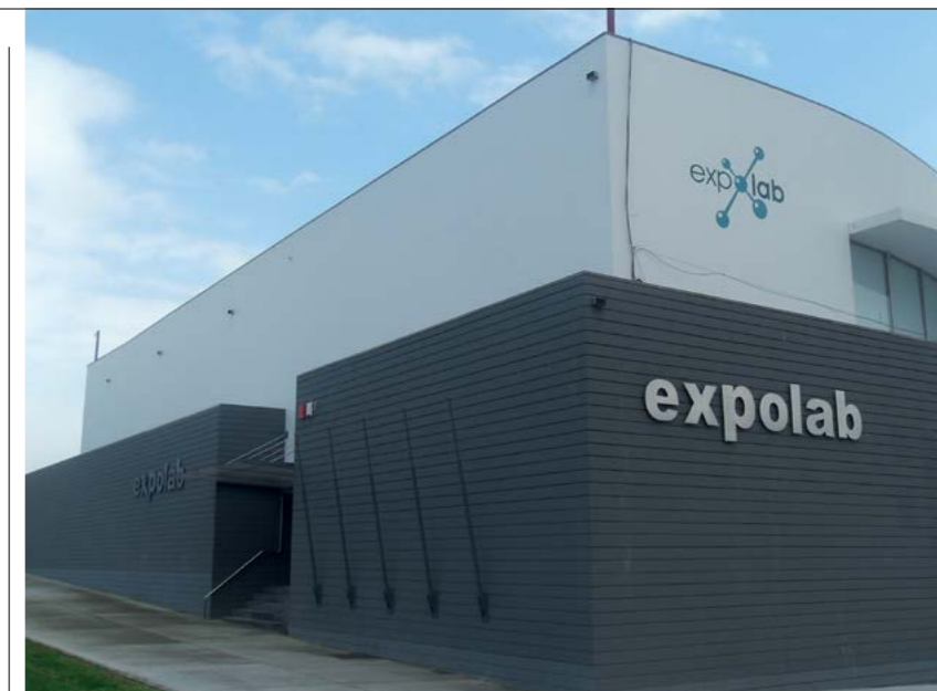
1 Edifício: mesmo à beira mar
