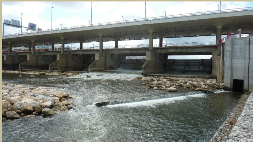
Açude-Ponte de Coimbra com passagem para peixes
