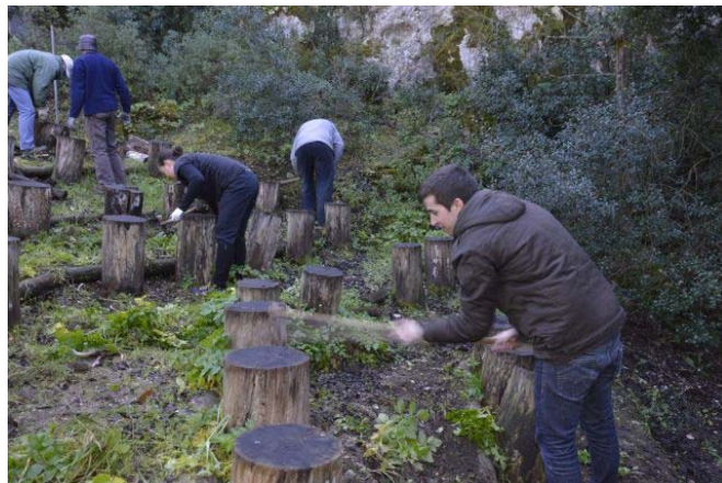
Observação do forno do cal | Recuperação do auditório
