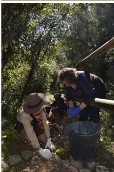
O Futuro está nas nossas mãos | Regularização de piso PP
