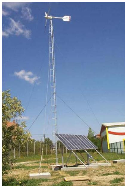
Sistema híbrido eólico-fotovoltaico para electrificação rural 1,1kWp
