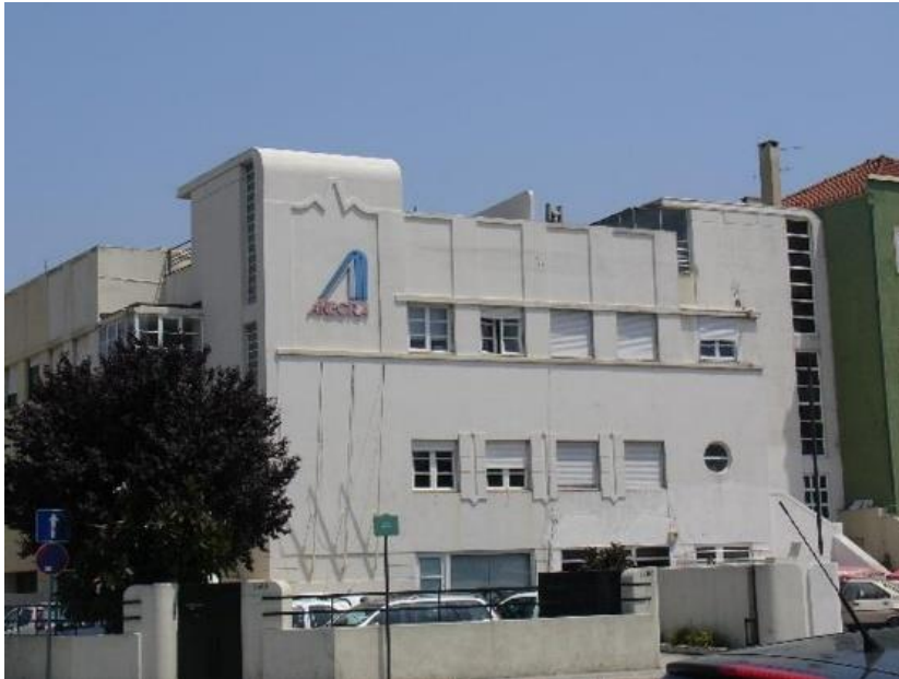
Figura 59-Fotografia exterior da Cooperativa do Pinheiro Manso.
