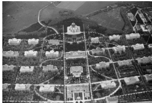
Hospital Psiquiátrico Steinhof, 1904-1907 Viena Otto Wagner, Ferdinand Muller
